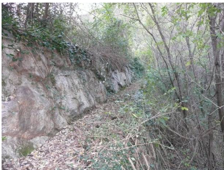
Figura 3.5 - Vista della sopraelevazione del muraglione d'argine del Rio Prietto.
