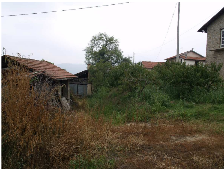
Figura 3.4-L'abitazione che subi gravi danni nel corso dell'attivazione del febbraio 1972 era ubicata in corrispondenza dell'attuale frutteto visibile nell'immagine. Cod danno 1974 - Foto del 06/09/2010
