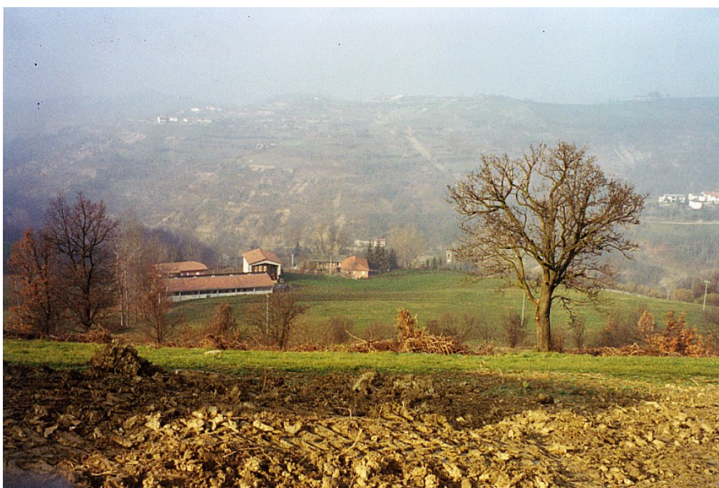
Figura 4.4 - Novembre 1994 - Vista generale dell'area in frana
