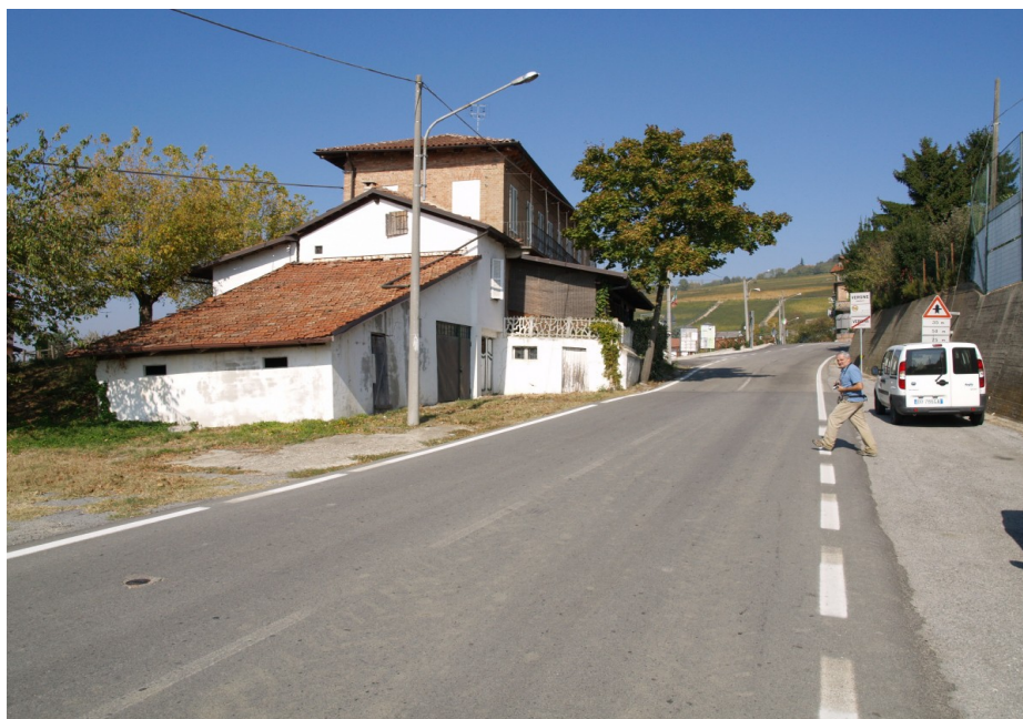
Figura 3.1 - pertinenze di un ex albergo vistosamente lesionate. L'edificio sorge in prossimità della scarpata destra (vedi foto Figura 4.3), in corrispondenza del toponimo "Rudere" riportato sulla cartografia IGM. Foto del 13/11/2011.
